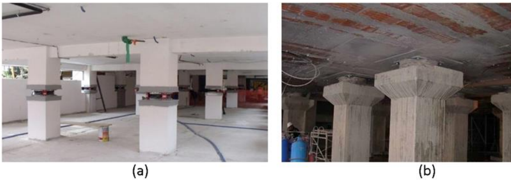
Şekil 9. (a), (b) Deprem İzolatörlerinin Yapıya Uygulanması
